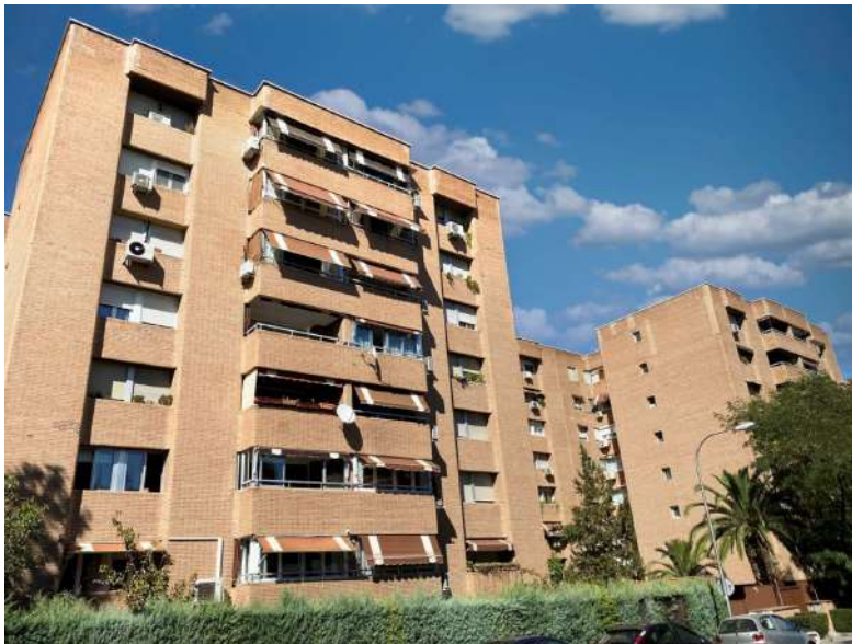
Fig. 17: Bloque de viviendas
